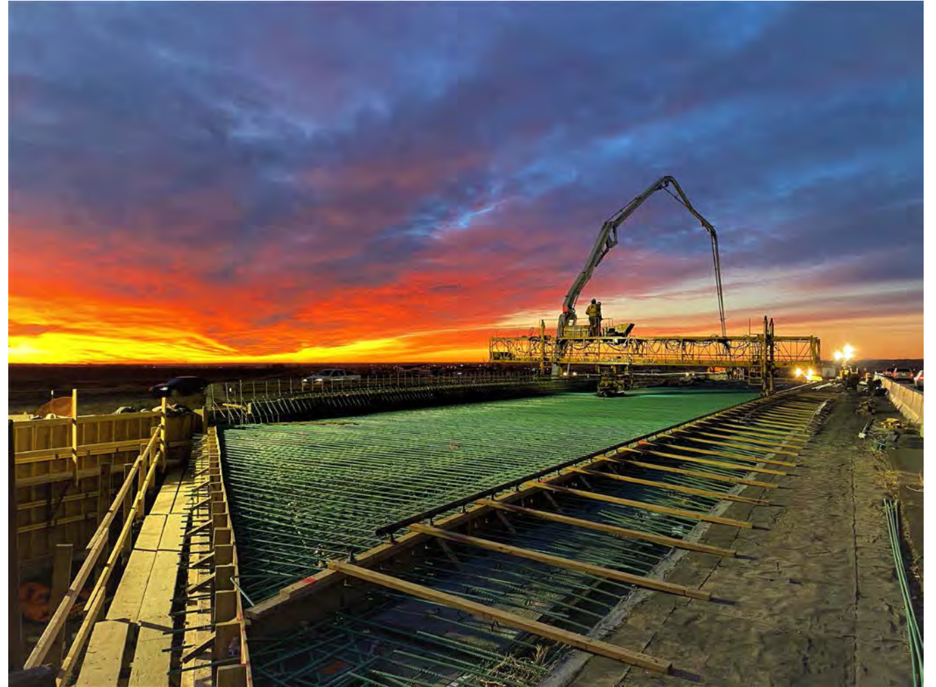
UPRR Bridge Deck Pour
