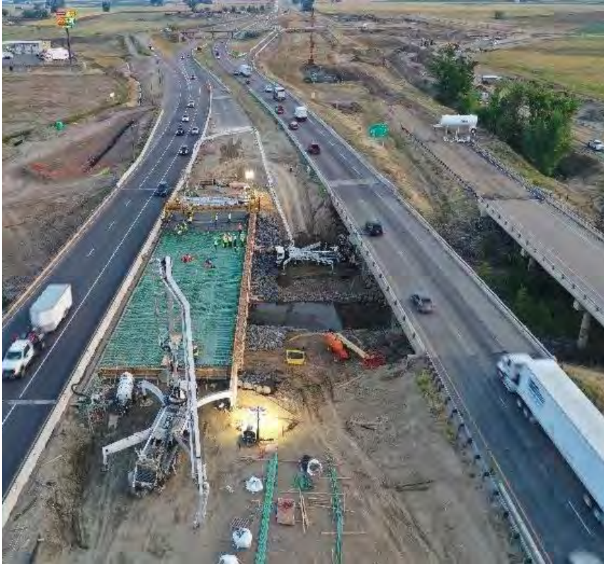
Little Thompson Bridge Deck Pour
